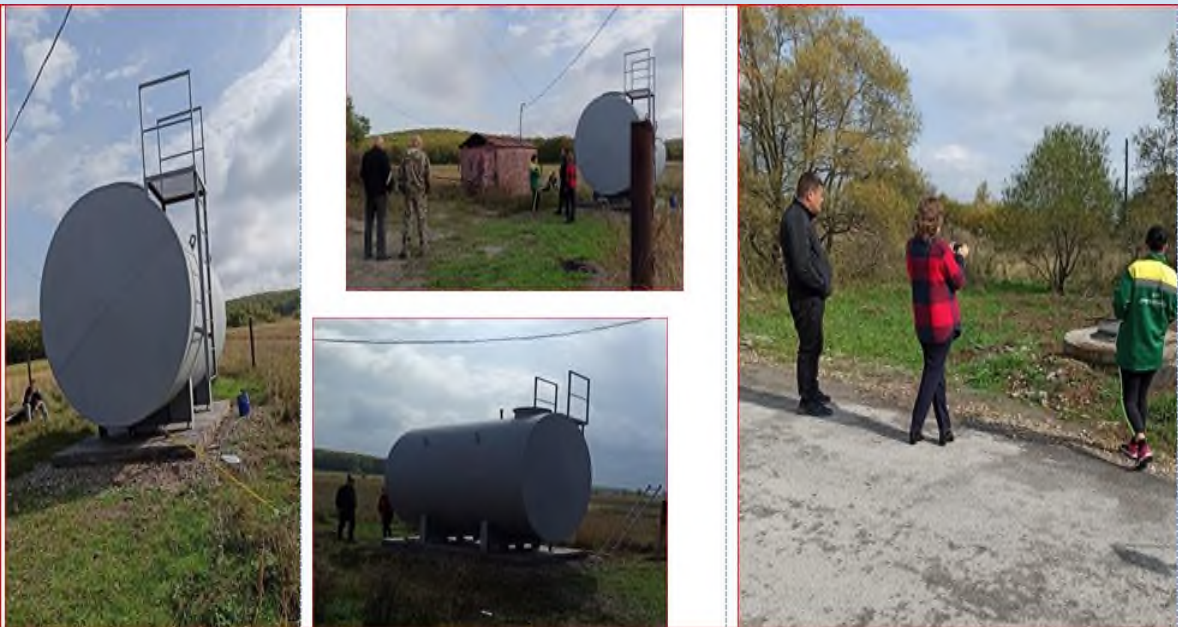
1. Работы по улучшению качества питьевого водоснабжения с.Павловка
