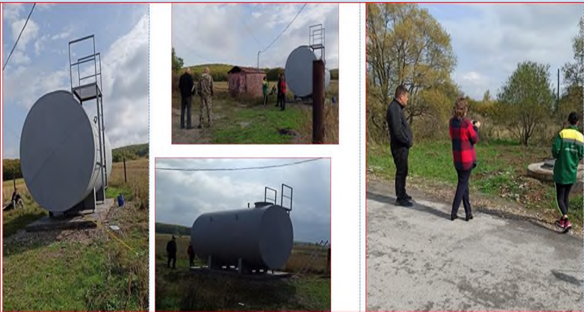
1. Работы по улучшению качества питьевого водоснабжения с.Павловка
